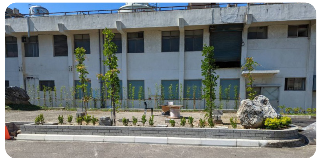
員工露天休憩區建置
